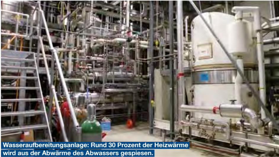
**Wasseraufbereitungsanlage: Rund 30 Prozent der Heizwärme wird aus der Abwärme des Abwassers gespeisen.**
