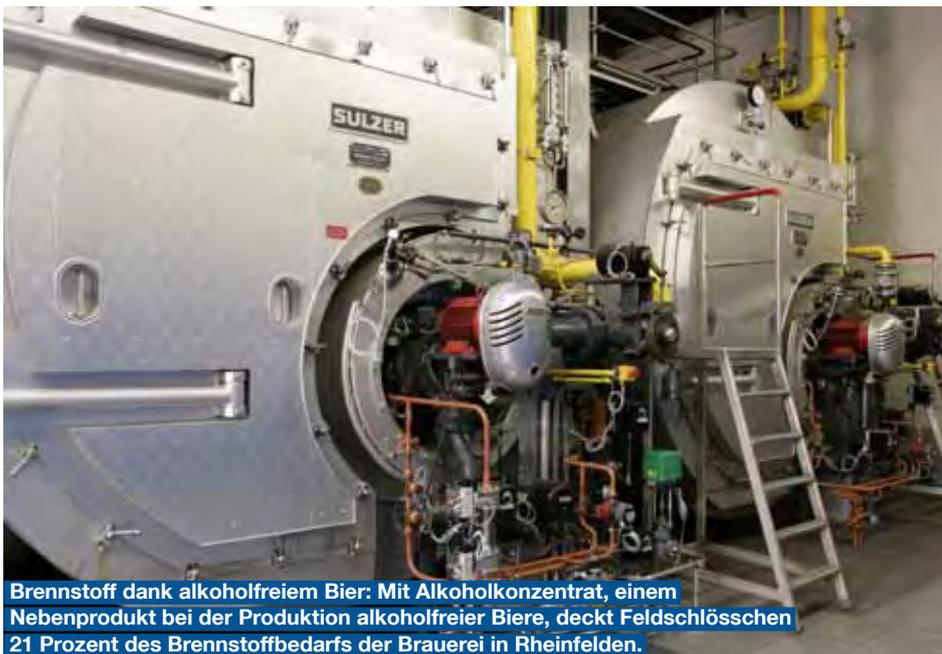
**Brennstoff dank alkoholfreiem Bier: Mit Alkoholkonzentrat, einem Nebenprodukt bei der Produktion alkoholfreier Biere, deckt Feldschlösschen 21 Prozent des Brennstoffbedarfs der Brauerei in Rheinfelden.**
