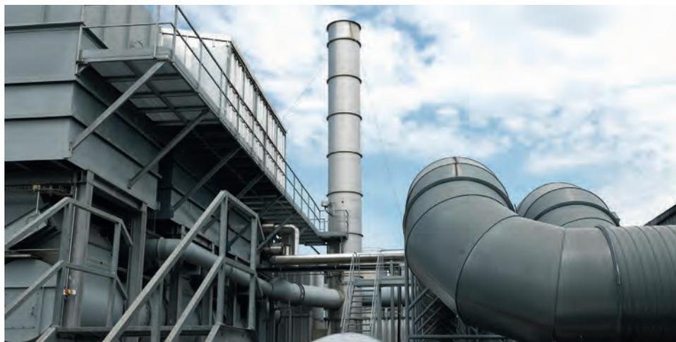
Die Abluftreinigungsanlage auf dem Dach der Wipf AG ist das Herzstück zur Steigerung der Energieeffizienz.
