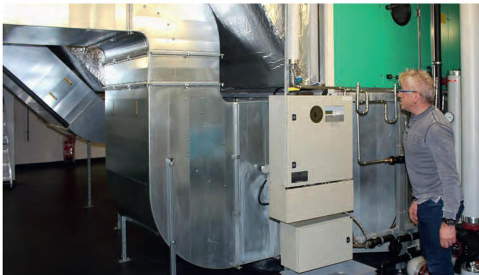
Wesentliche Energieeinsparungen waren dank einer intelligenten Zeitschaltung der Ventilationsanlagen möglich, die in der Uhrmacher-Manufaktur für die unerlässlichen konstanten Temperatur- und Feuchtigkeitsbedingungen sorgen.
