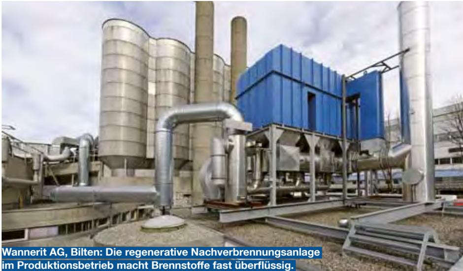
Wannerit AG, Bilten: Die regenerative Nachverbrennungsanlage im Produktionsbetrieb macht Brennstoffe fast überflüssig.
