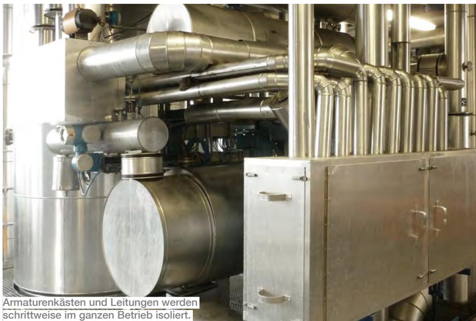
Armaturenkästen und Leitungen werden schrittweise im ganzen Betrieb isoliert.
