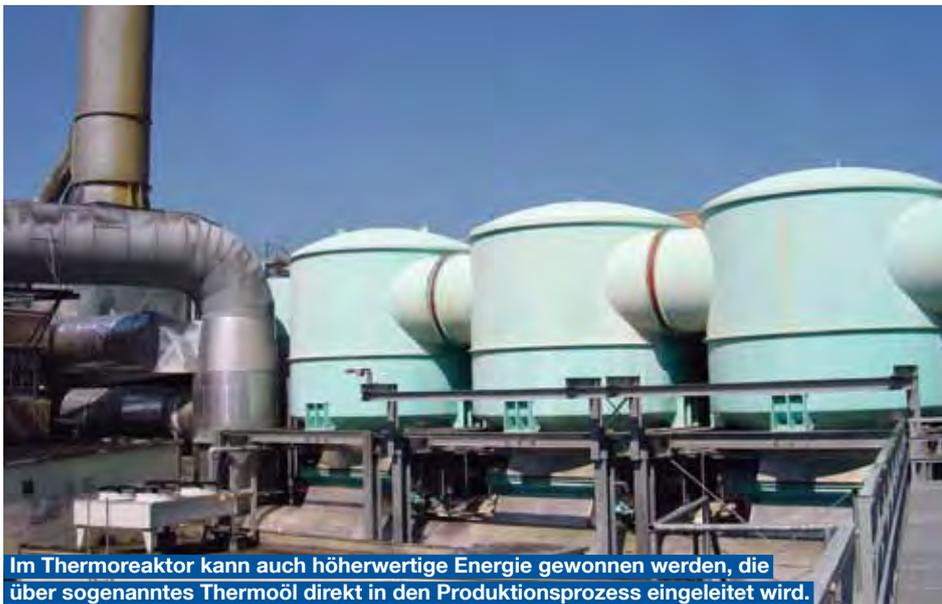
Im Thermoreaktor kann auch höherwertige Energie gewonnen werden, die über sogenanntes Thermoöl direkt in den Produktionsprozess eingeleitet wird.
