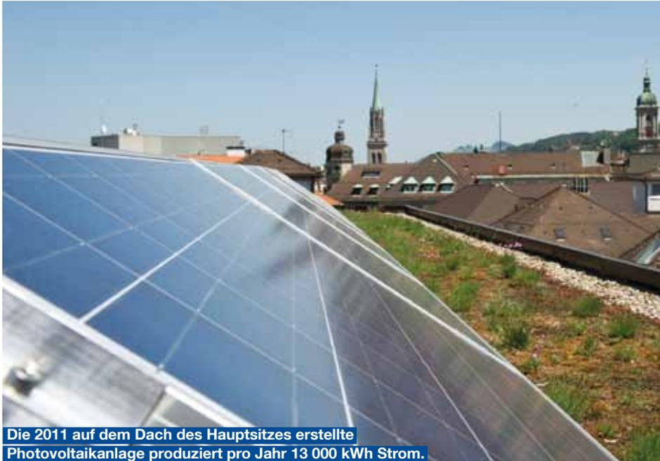
Die 2011 auf dem Dach des Hauptsitzes erstellte Photovoltaikanlage produziert pro Jahr 13 000 kWh Strom.
