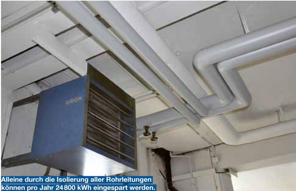
Alleine durch die Isolierung aller Rohrleitungen können pro Jahr 24800 kWh eingespart werden.
