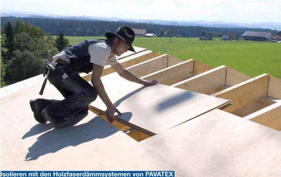
Isolieren mit den Holzfaserdämmsystemen von PAVATEX
