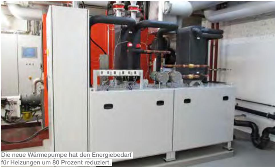
Die neue Wärmepumpe hat den Energiebedarf für Heizungen um 80 Prozent reduziert.
