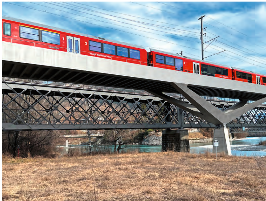
Bild 1: Für die Herstellung von Stahlbrücken (Tragwerke) können sowohl die SIA 263/1:2020 als auch die SN EN 1090 herangezogen werden.
