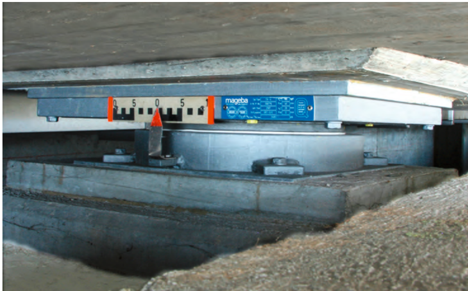
Bild 4: Als Bauprodukt in unserer Branche gilt beispielsweise ein Brückenlager.
